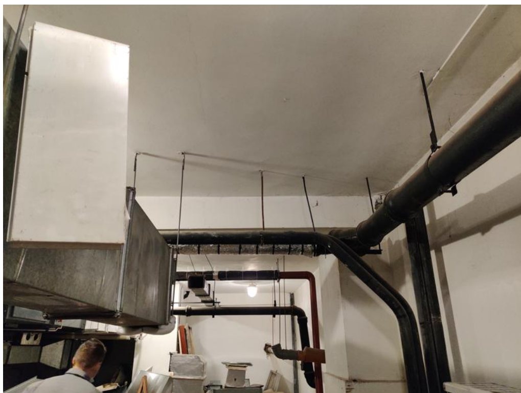
Zdj. 6 Widok na strop nad piwnicą. Brak widocznych zarysowań oraz ponadnormatywnych ugięć konstrukcji stropu.
