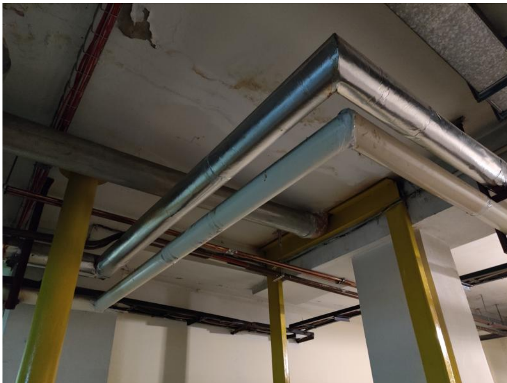
Zdj. 5 Istniejące wzmocnienie stropu ramą stalową w miejscu montażu zbiornika zlokalizowanego na istniejącej konstrukcji stropu ceramicznego.
