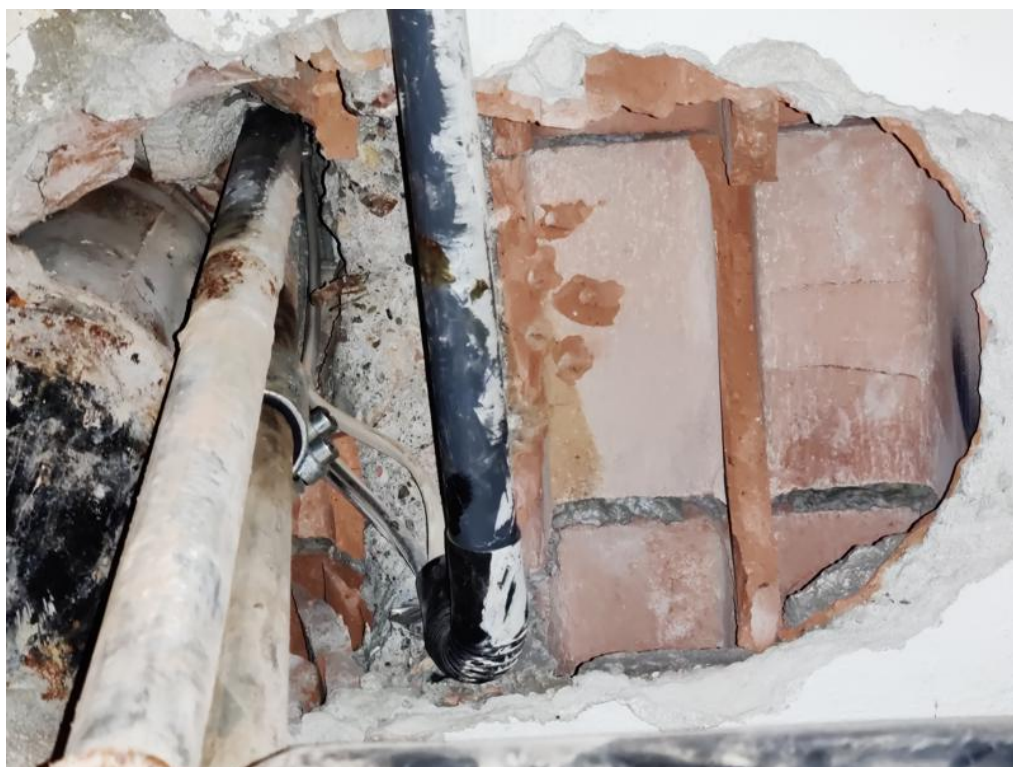
Zdj. 1 Widoczny pustak ceramiczny typu Akermana oraz żebro żelbetowe. Strop nad piwnicą.
