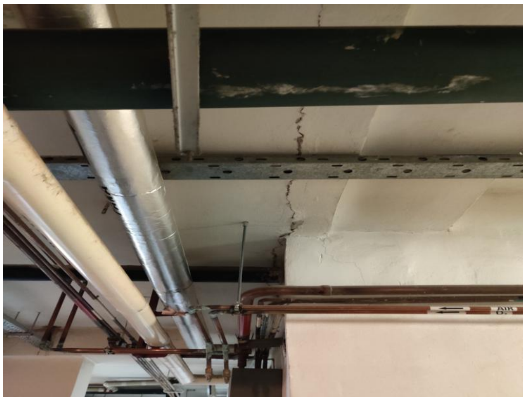
Zdj. 3 Zarysowanie w miejscu występowania dylatacji między częściami budynku.
