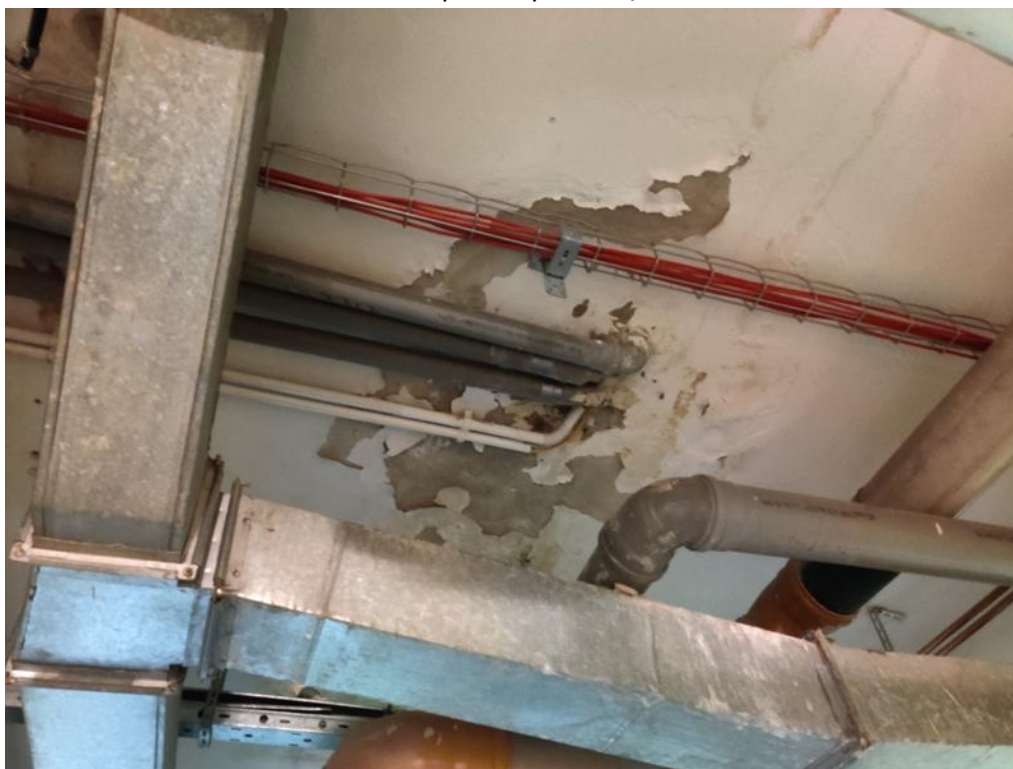
Zdj. 2 Zawilgocenie stropu w miejscu przejścia instalacji.
