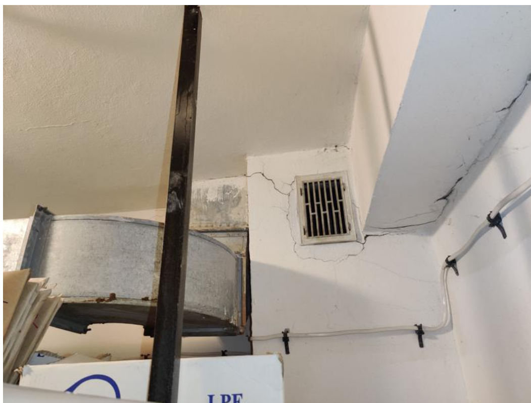
Zdj. 4 Wystąpienie zarysowania na granicy podciągu żelbetowego oraz ścianek działowych przy szachcie instalacyjnym.
